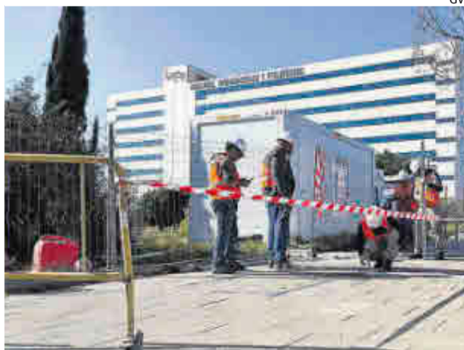
Primeros operarios al inicio de las obras del centro.
